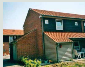
80'erne var rækkehusenes storhedstid. Som små landsbyer med gader og stræder bygges rækkehusene i store klynger.
