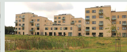
Moderne byggeri har ofte LAR - Lokal Afledning af Regnvand – bl.a. med sumpbede og græs på taget, der gør at regnvandet fordamper i området.
