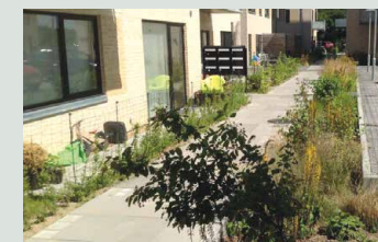
Moderne byggeri har ofte LAR - Lokal Afledning af Regnvand – bl.a. med sumpbede og græs på taget, der gør at regnvandet fordamper i området.
