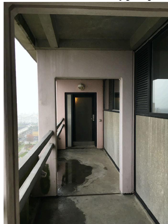
Eksisterende facade, Bygning 63
