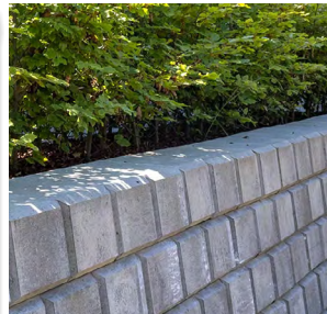
Ny støttemur ved indkørsel
