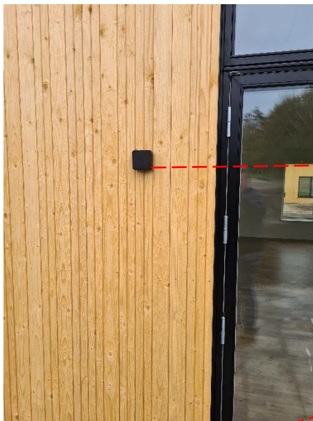
Aflæsning af elmåler. Elmåler aflæses digitalt.
